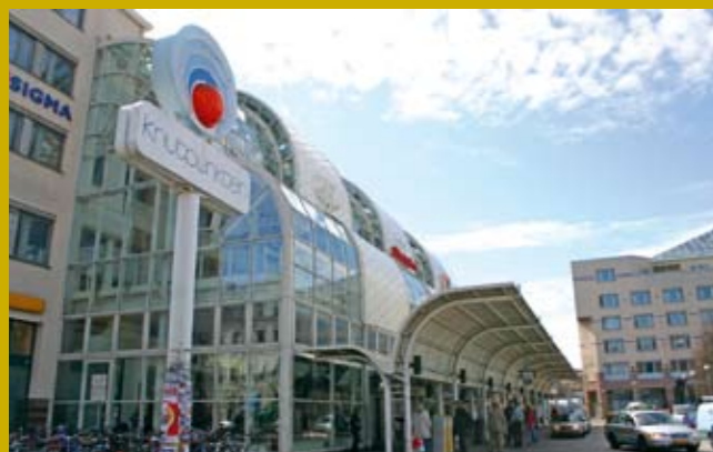
Helsingborgs centralstation, "Knutpunkten". Foto: Anita Göransson.
