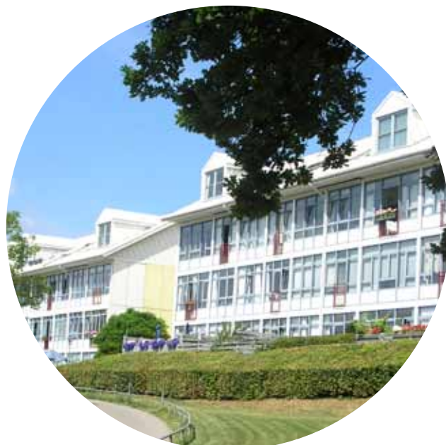
Förtätning kan även betyda nya lägenheter på befintliga hus. Hus med platta tak i Vapnagård har fått sadeltak och extra lägenheter. Foto: Marianne Dock.
